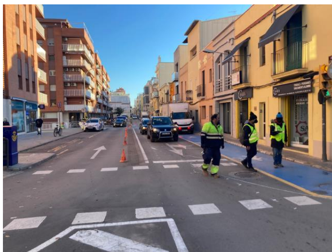
Es reordena la zona de càrrega i descàrrega
